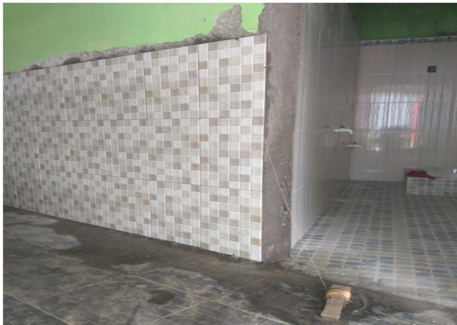
Pembangunan Mushola Al Karim, Karang putih sebelum & sesudah
